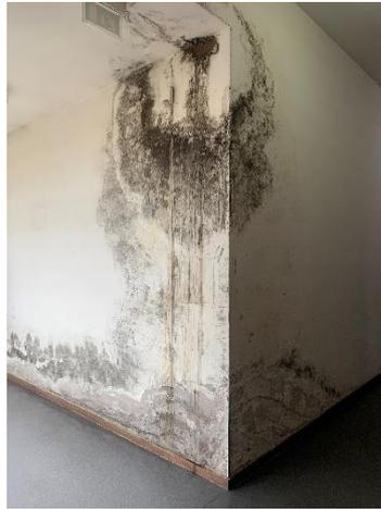
Figura 3 – Temperaturas muito reduzidas e humidade avançada em corredor interno do PT da Maia
